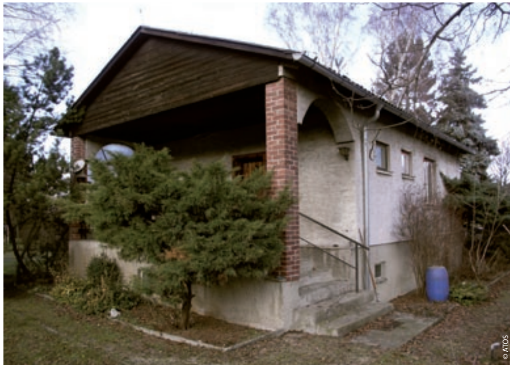
Dieses Musterhaus, das knapp 40 Jahre alt ist, dient als Grundlage für die Kostenangaben in diesem Beitrag
