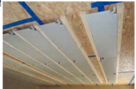
Die Außenwände des Hauses bestehen aus Kreuzlagenholz und einer Staffelkonstruktion mit Zellulosedämmung. Im Obergeschoss wurden die Heizflächen als Deckenstrahlungsheizung ausgeführt.
