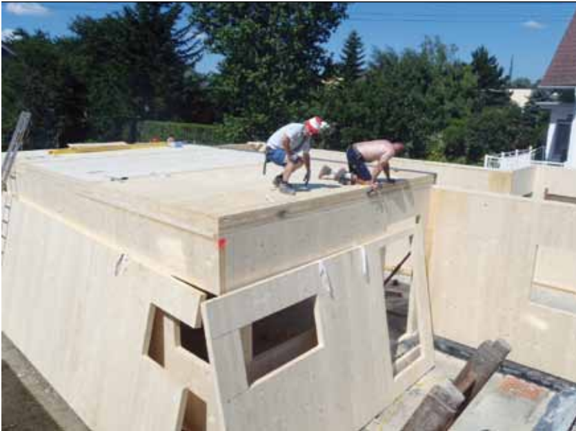
Die Außenwände des Hauses bestehen aus Kreuzlagenholz und einer Staffelkonstruktion mit Zellulosedämmung. Im Obergeschoss wurden die Heizflächen als Deckenstrahlungsheizung ausgeführt.
