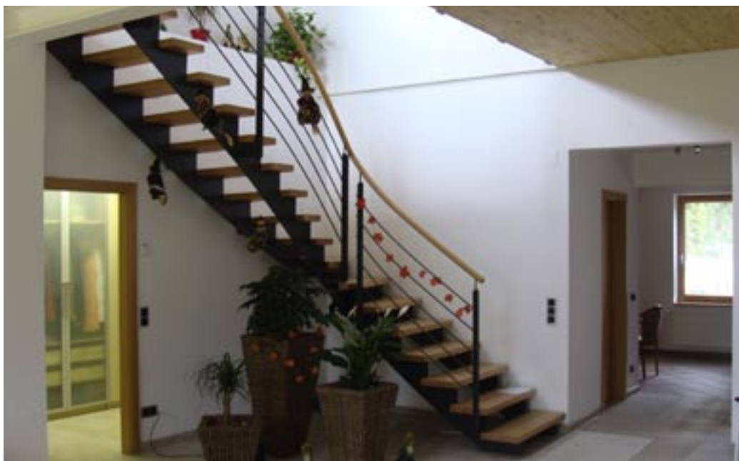
Das neue Obergeschoss ist durch eine freitragende Treppe attraktiv erschlossen
