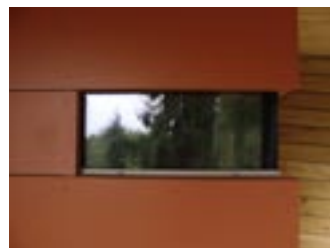
Detail der neuen Fassade
