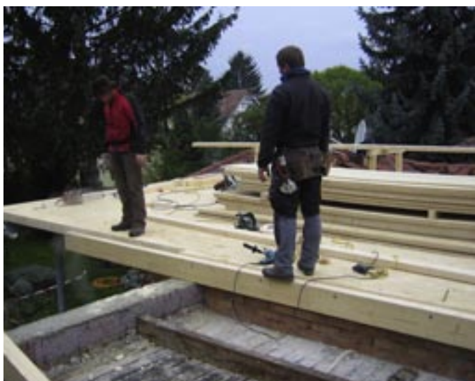
Die Bewohnbarkeit des Objektes im Umbau war eine Herausforderung
