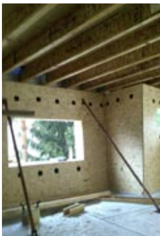
Errichtung des Obergeschosses
