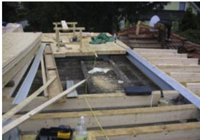
Die neue Holzdecke wird auch zur Leitungsführung verwendet
